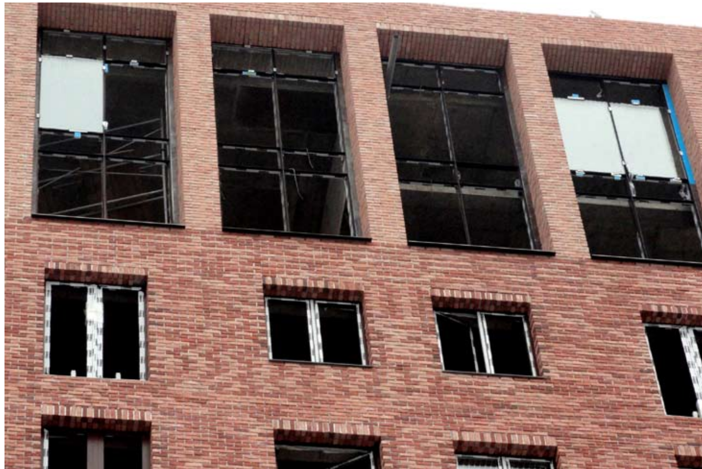
Облицовка колонн, горизонтальных поверхностей, перемычек, гладь стены
