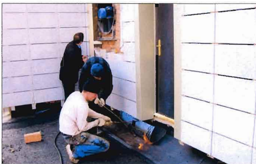
Фото 4. Огневые работы при наплавлении гидроизоляции вблизи нижнего прудуха воздушной прослойки
