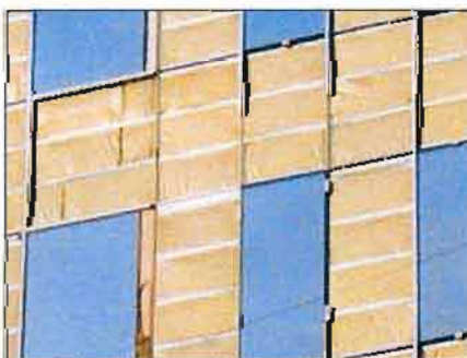
Фото 2. Пример установки полиэтиленовой пленки в качестве ветрозащиты
