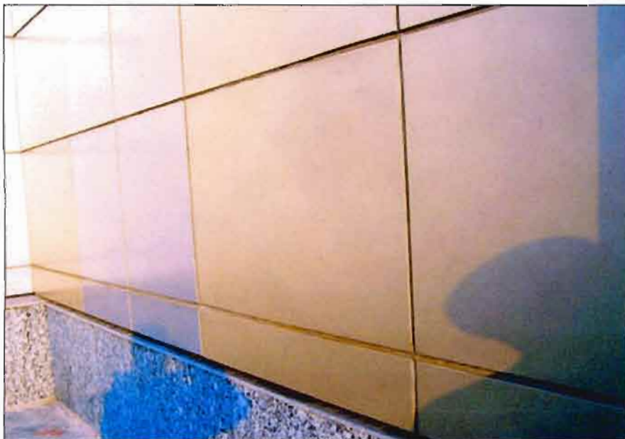
Фото 7. Фрагмент вентилируемого фасада с закрытыми зазорами между облицовочными плитками
